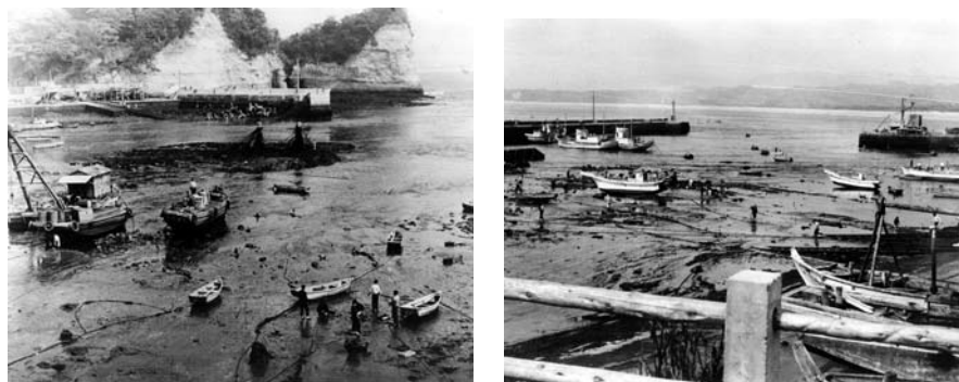
図 2.2-1 チリ地震津波の状況（左：平潟漁港、右：大津漁港(共に北茨城市)）
