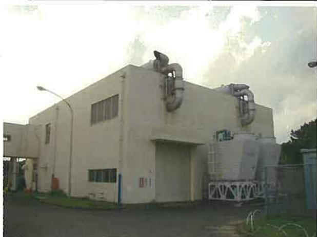
写真 28 中間開閉所・第2 中間開閉所
