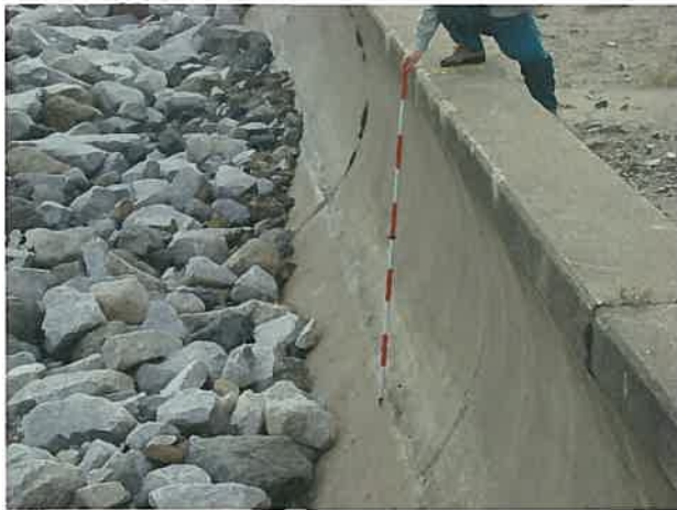
写真 19 海岸（第二排水溝付近）の護岸
